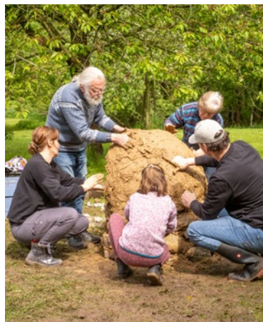
Unten: Beim Verputzen der Kuppel können die durch die unterschiedlichen Steingrößen entstandenen „Dellen“ ausgeglichen werden. Bei solch dicken Lehmschichten empfiehlt sich der Einsatz von Stroh um Risse zu minimieren. Stroh dient später auch gut zum Entfachen des Feuers mit steinzeitlichen Methoden, denn natürlich möchte Harm Paulsen so einen Ofen dann auch stilecht anfeuern.
