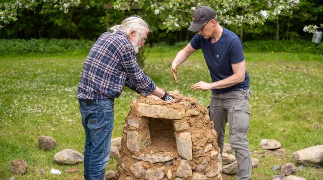
Oben: Essenziell beim Aufschichten der Kuppel ist es, mit Lehm von außen den Steinen ein Gegengewicht zu geben, damit sie nicht nach innen fallen. Sobald oben ein Ringabschluss ist, stabilisiert sich die Kuppel.
